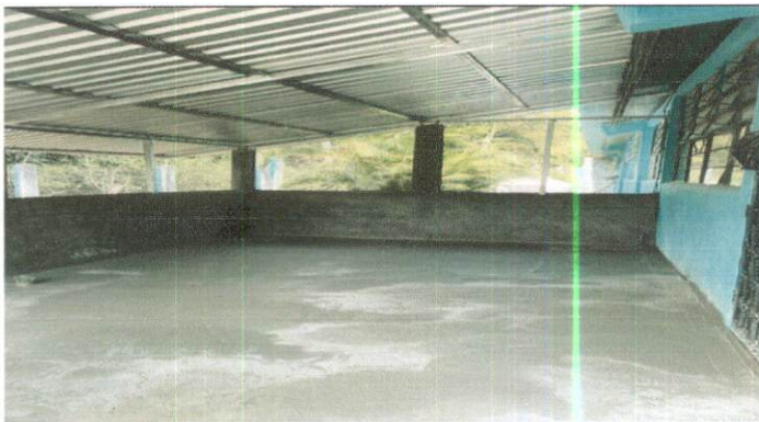
Foto 2: Mejoramiento de piso de cocina
