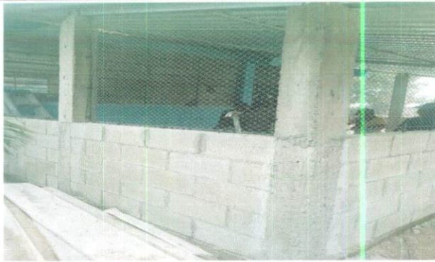
Foto1: Mejoramiento de cocina, estructura y techado de lamina troquelada calibre 26
