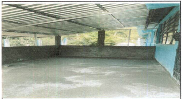
Foto 2: Mejoramiento de piso de cocina
